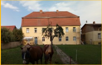
Bild: Das Gutshaus Pitschen während der Sanierung der Fassade im Sommer 2020. Das ehemalige Rittergut blickt auf eine Jahrhunderte alte Geschichte zurück. www.gutshaus-pitschen.jimdofree.com
